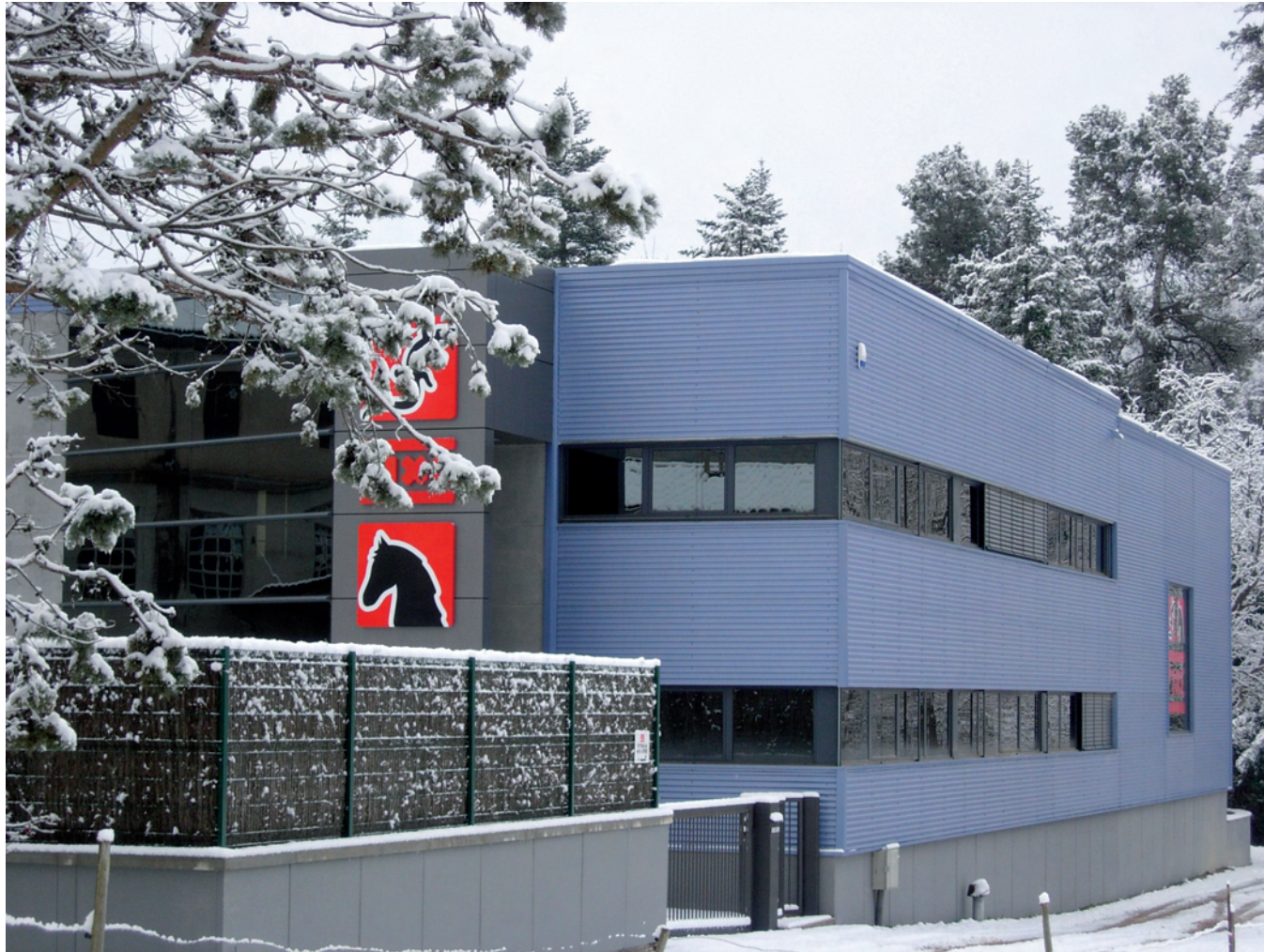
Instalaciones FIXE. Installations FIXE. FIXE installations. Sant Quirze de Besora. Barcelona, Spain.
